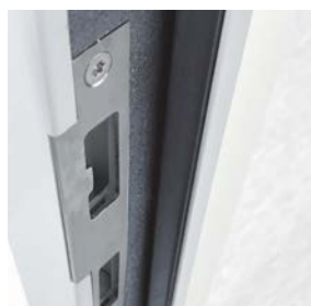
Zapadací plech z nerezovej ocele
